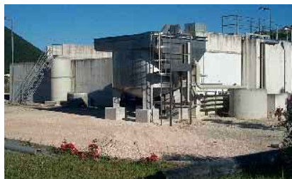
Flottatore ad aria dissolta installato in testa ad un impianto Municipale per l'abbattimento dei grassi in eccesso
